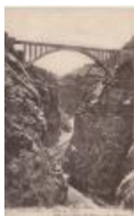
8. Guillaumes. Pont du train dans les gorges du Var. (06053-IM-00148)
