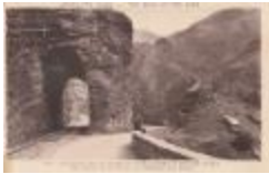
126. Le Tunnel dans les Gorges de Guillaumes et de Daluis (A.M.) (06053-IM-00142)
