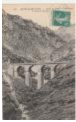
486. Alpes Maritimes. Route de Daluis à Guillaumes, le Pont de Berthet (06053-IM-00144)
