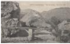
Daluis (Alpes Maritimes. Vue panoramique. _ Pont de la Faille (06053-IM-00036)
