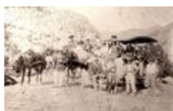
construction de la route - Daluis (06053-IM-01269)
