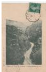
9. route des Gorges de Daluis à Guillaumes (A.M.) (06053-IM-00152)
