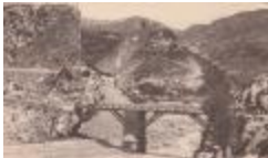
3. - Haute vallée du Var. - Passerelle Saint-Léger et Village de Daluis (06053-IM-00038)
