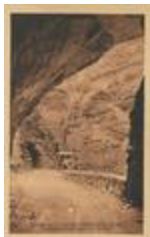
Environs de Puget-Théniers (A.-M.) - Tunnel des Gorges du Daluis (06016-IM-00521)
