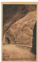
Environs de Puget-Théniers (A.-M.) - Tunnel des Gorges du Daluis (06016-IM-00921)
