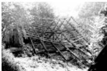
[la grange dite la sousta] (06056-IM-00369)
