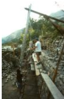
[construction du mur de soutènement de la terrasse de la Sousta - Estenc (Entraunes)] (06056-IM-00373)
