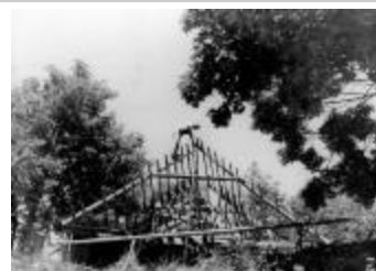
[La grange dite la Sousta] (06056-IM-00371)
