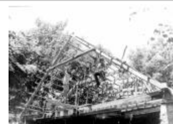
[La grange dite la Sousta] (06056-IM-00372)
